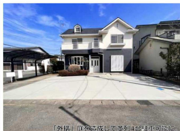
「外構」庭を造成して並列4台駐車可能に。
