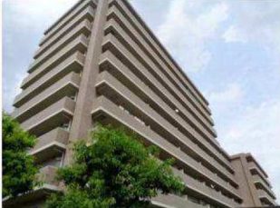
マンション外観
